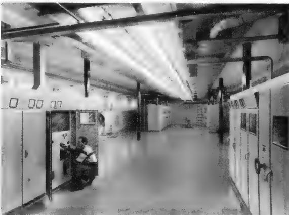
Links: Bild 2. Unter dem Senderaal befindet sich dieser Raum für die Stromversorgungs- und Gleichrichteranlagen; die entsprechenden Aggregate sind jeweils direkt unter den darüber stehenden Sendern angeordnet
